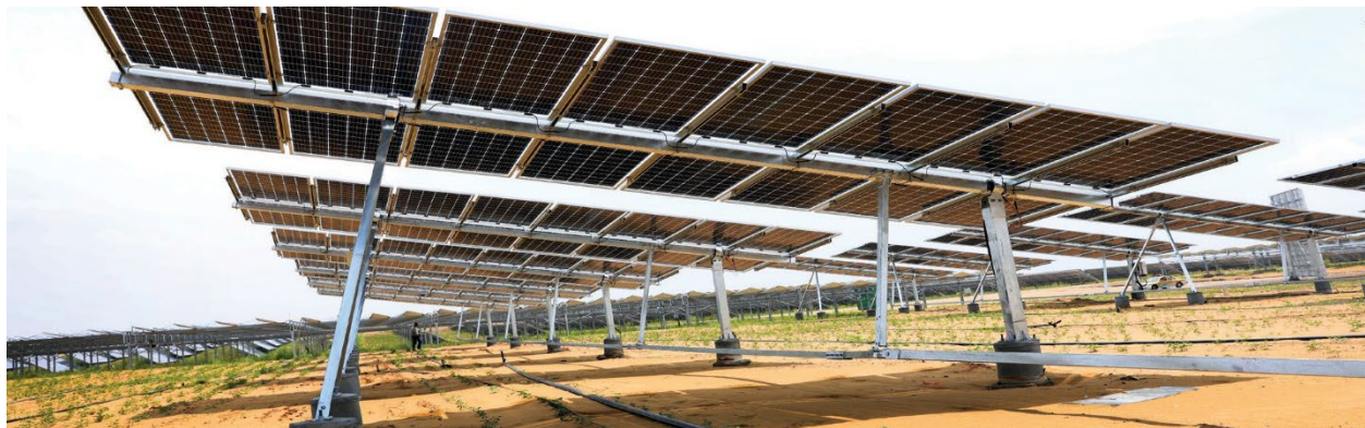
Obrázek 7 Instalace bifaciálního modulu pomocí šroubů
